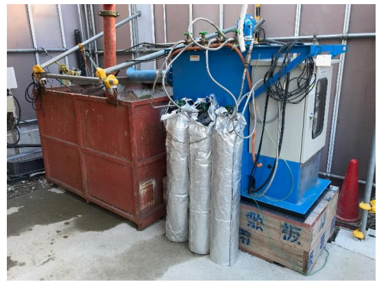
写真4-1-6-10 工事排水の適切な処理
