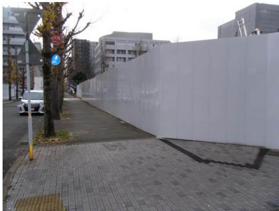
写真4-1-6-1 仮囲い等の設置
