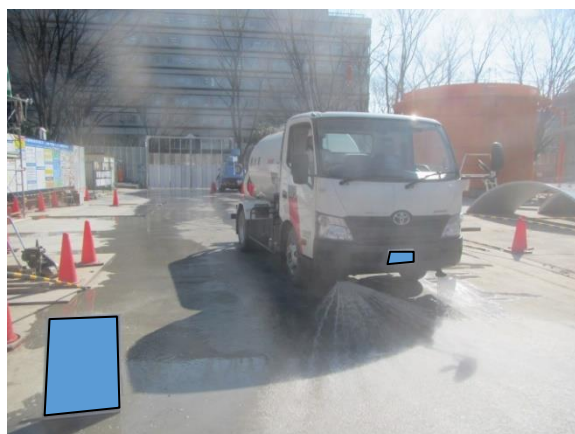
写真4-1-5-5 工事現場の清掃、散水
