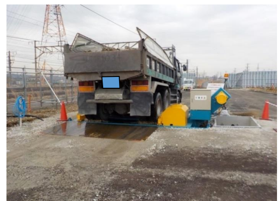
写真4-1-3-6 資材及び機械の運搬に用いる車両 の出入口の清掃及び散水、タイヤの 洗浄
