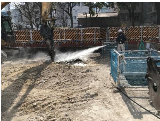
写真 4-1-6-5 工事現場の清掃、散水
