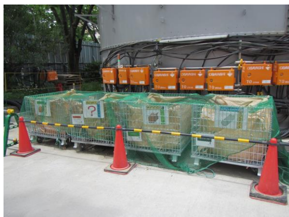
写真4-1-5-11 副産物の分別、再資源化
