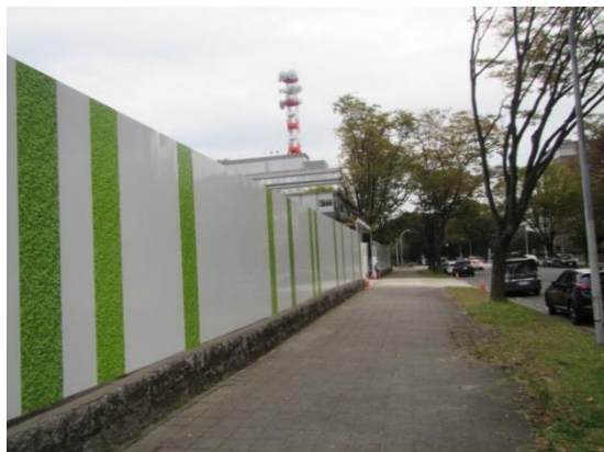
写真4-1-5-1 仮囲い等の設置
