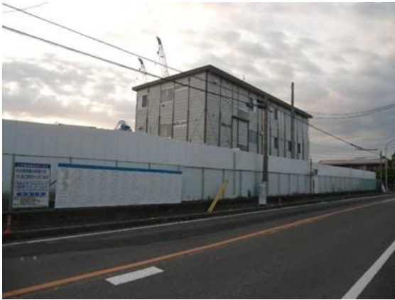
写真4-1-2-1 仮囲い等の設置
