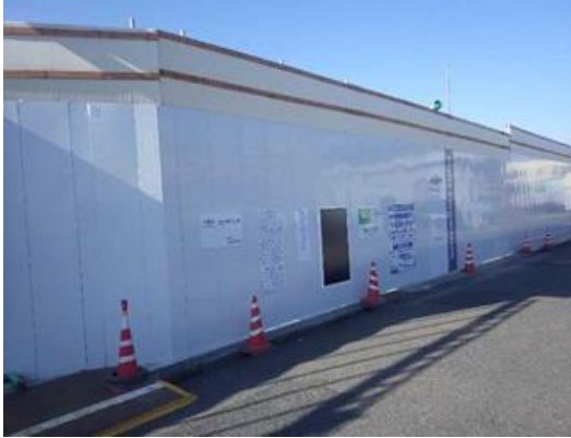
写真4-1-4-1 仮囲い・防音シート等の設置
