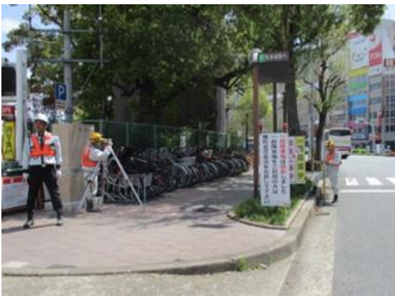
写真4-1-7-9 山留め材及び周辺地盤の計測管理
