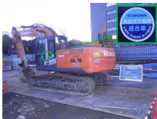
写真4-1-5-2 排出ガス対策型建設機械の採用
