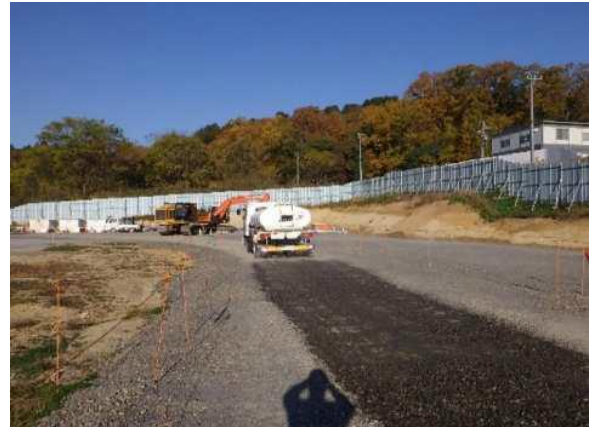
写真4-1-1-4 工事現場の清掃、散水
