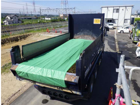
写真4-1-3-7 荷台への防塵シート敷設及び散水
