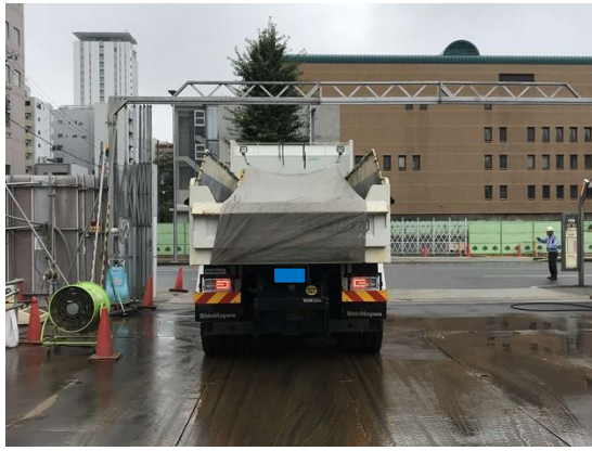
写真4-1-6-7 荷台への防塵シート敷設及び散水
