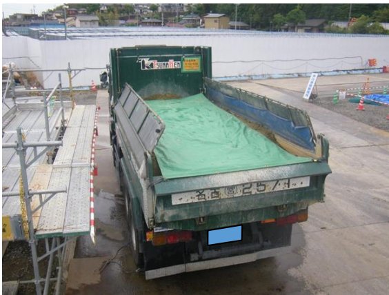
写真4-1-2-5 荷台への防塵シート敷設及び散水
