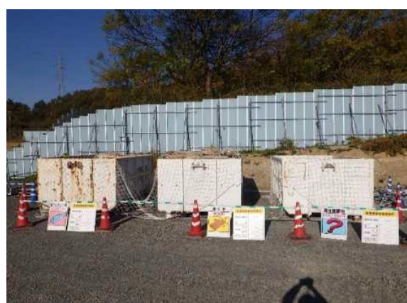
写真4-1-1-10 副産物の分別、再資源化
