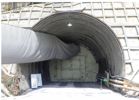
写真4-1-1-11 トンネル坑口への防音扉の設置
