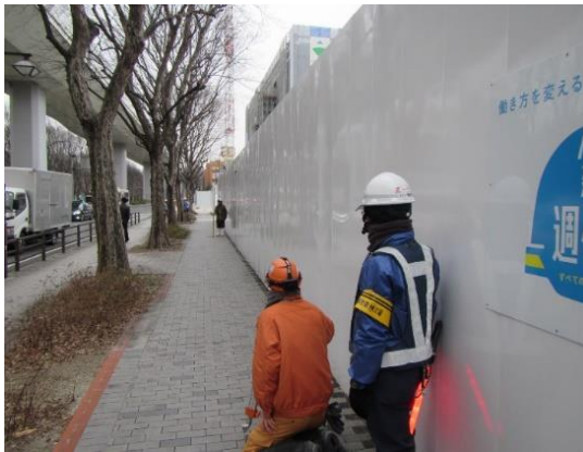
写真4-1-6-9 山留め材及び周辺地盤の計測管理
