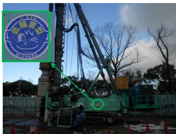
写真4-1-5-4 低騒音型建設機械の採用
