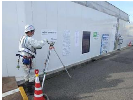
写真4-1-4-8 周辺地盤の計測管理
