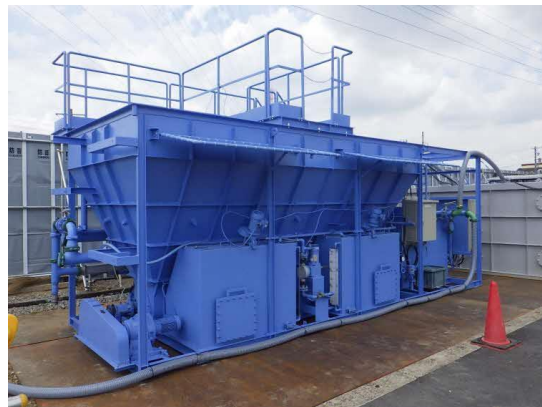
写真4-1-3-8 工事排水の適切な処理
