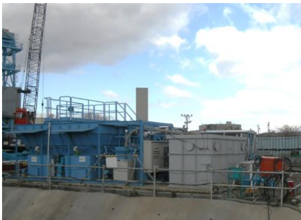
写真4-1-2-7 工事排水の適切な処理
