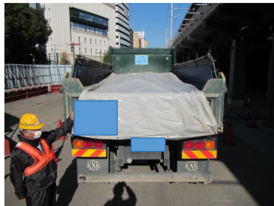
写真4-1-7-6 荷台への防塵シート敷設及び散水
