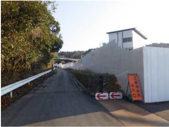
写真4-1-1-1 仮囲い等の設置
