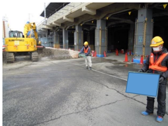
写真 4-1-7-5 工事現場の清掃、散水
