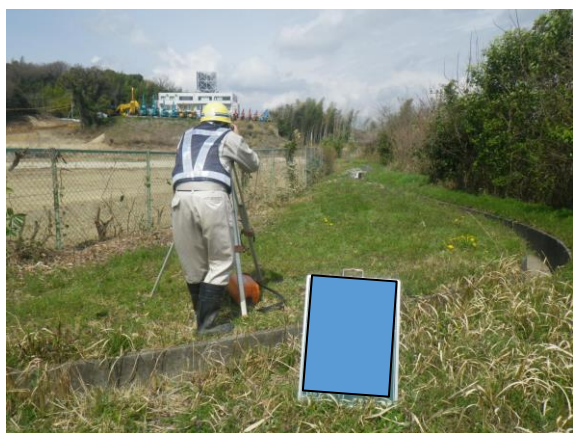
写真4-1-2-9 山留め材及び周辺地盤の計測管理
