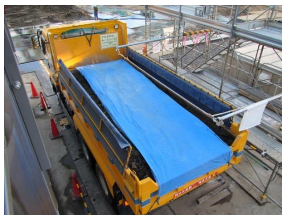
写真4-1-5-6 荷台への防塵シート敷設及び散水
