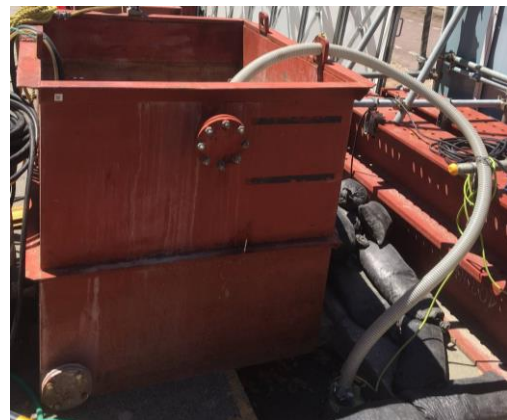
写真4-1-7-10 工事排水の適切な処理
