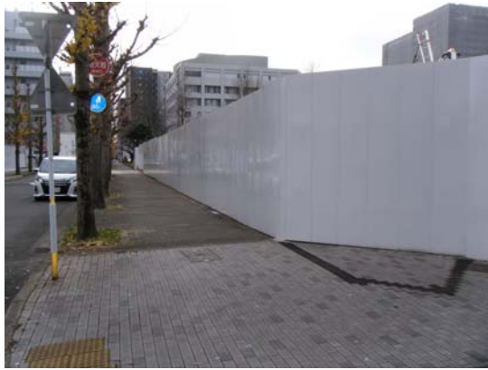
写真4-1-5-1 仮囲い等の設置
