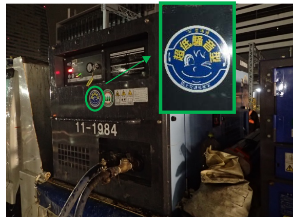
写真4-1-6-4 低騒音型建設機械の採用
