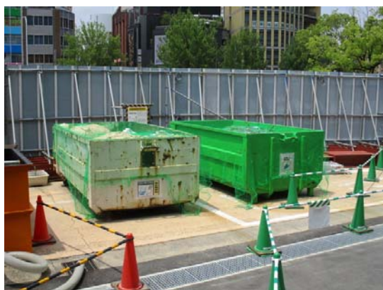
写真4-1-6-11 副産物の分別、再資源化
