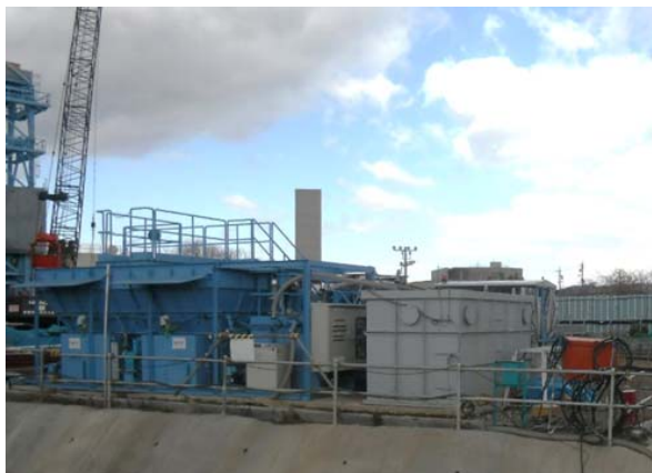
写真4-1-2-7 工事排水の適切な処理
