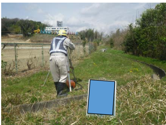
写真4-1-2-9 山留め材及び周辺地盤の計測管理
