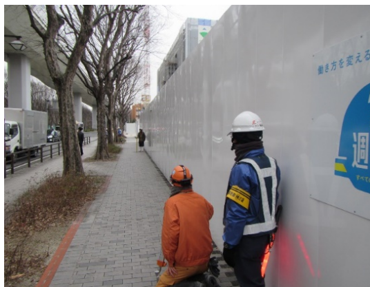
写真4-1-5-8 周辺地盤の計測管理
