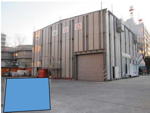
写真4-1-4-5 防音ハウスの設置
