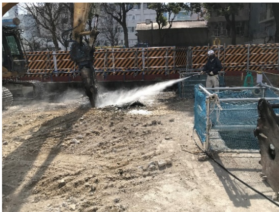
写真 4-1-5-5 工事現場の清掃及び散水
