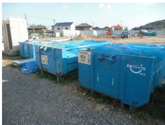
写真4-1-2-11 副産物の分別、再資源化
