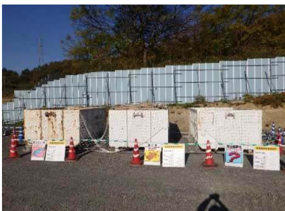
写真4-1-1-9 副産物の分別、再資源化
