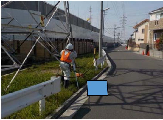
写真4-1-3-7 周辺地盤の計測管理
