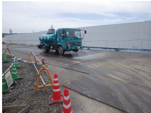
写真4-1-2-4 工事現場の清掃、散水
