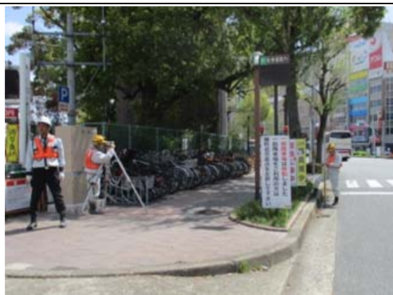
写真4-1-6-10 山留め材及び周辺地盤の計測管理
