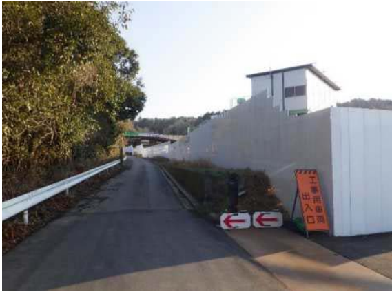
写真4-1-1-1 仮囲い等の設置
