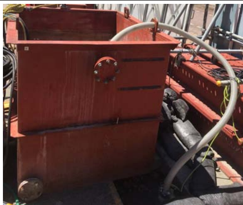
写真4-1-6-8 工事排水の適切な処理
