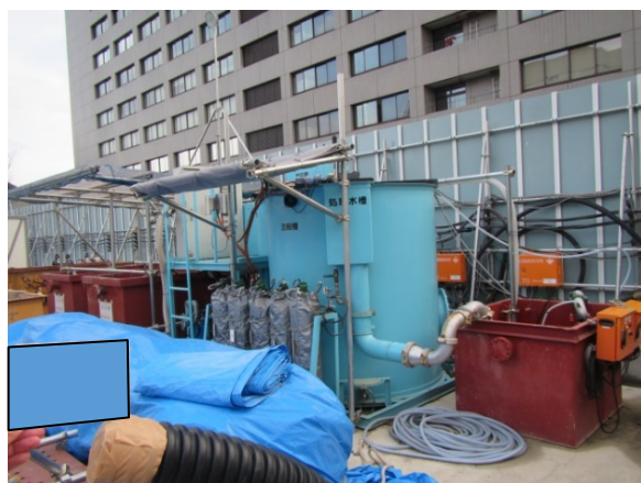
写真4-1-4-9 工事排水の適切な処理
