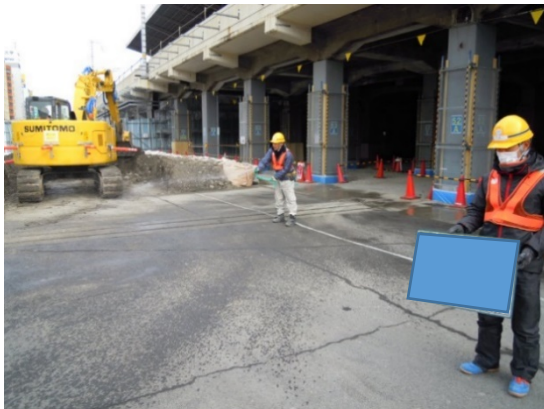
写真 4-1-6-5 工事現場の清掃、散水
