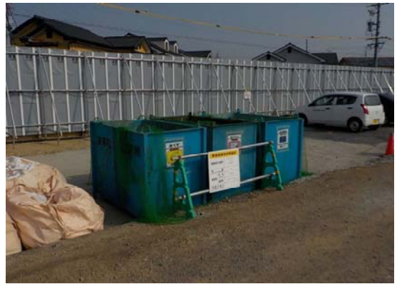
写真4-1-3-8 副産物の分別、再資源化
