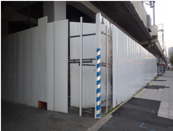
写真4-1-6-1 仮囲い等の設置
