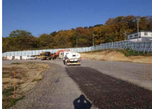
写真4-1-1-4 工事現場の清掃及び散水
