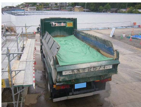
写真4-1-2-5 荷台への防じんシート敷設及び散水
