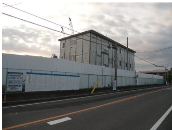
写真4-1-2-1 仮囲い等の設置
