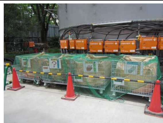
写真4-1-4-12 副産物の分別、再資源化
