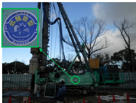
写真7-1-1-4 低騒音型建設機械の採用
