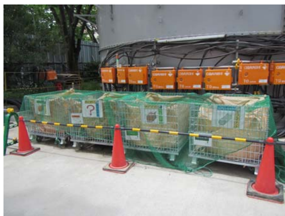
写真7-1-1-12 副産物の分別、再資源化
