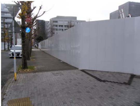
写真7-1-2-1 仮囲い等の設置
