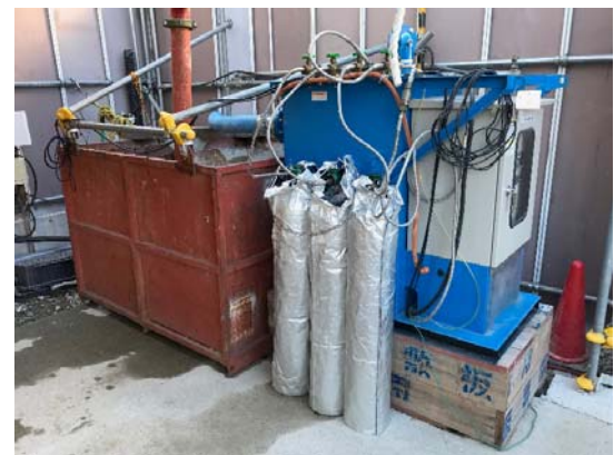
写真7-1-2-8 工事排水の適切な処理
