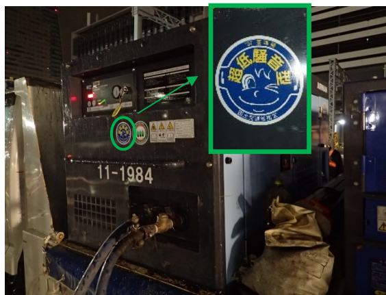
写真 7-1-3-3 低騒音型建設機械の採用
