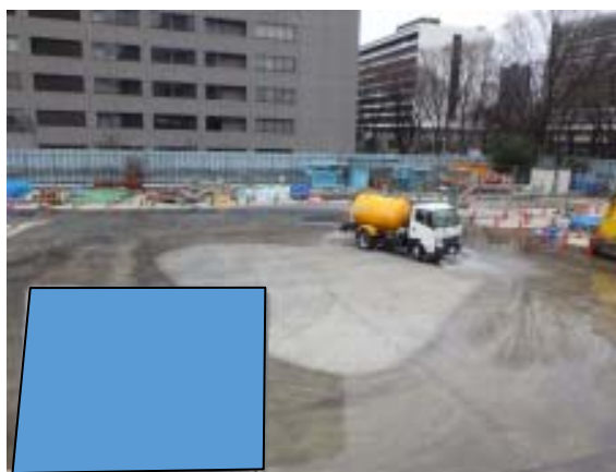
写真7-1-1-6 工事現場の清掃、散水
