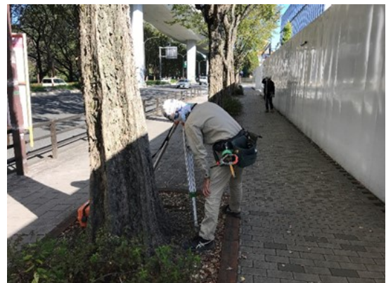
写真7-1-2-10 山留め材及び周辺地盤の計測管理
