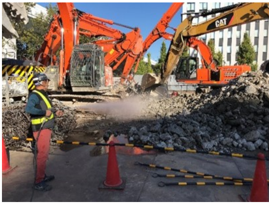
写真7-1-2-5 工事現場の清掃、散水
