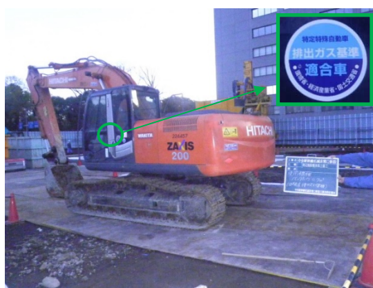
写真7-1-1-2 排出ガス対策型建設機械の採用
