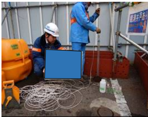
写真 7-1-3-9 地下水の継続的な監視
