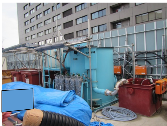
写真7-1-1-9 工事排水の適切な処理
