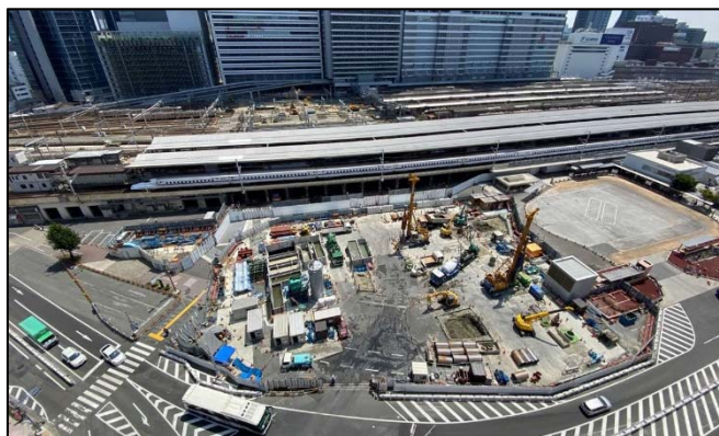
写真 3-2-3-1(5) 名古屋駅（中央工区全景）
