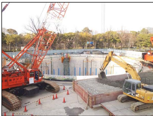
写真 3-2-3-1(1) 名城非常口（地上部）
