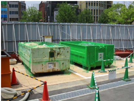
写真 7-1-3-11 副産物の分別、再資源化
