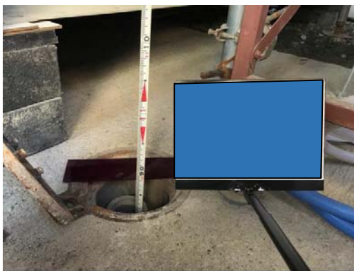
写真7-1-2-9 地下水の継続的な監視
