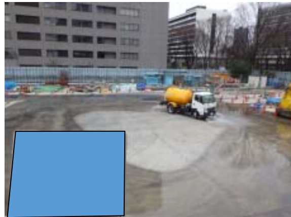
写真7-1-1-6 工事現場の清掃、散水
