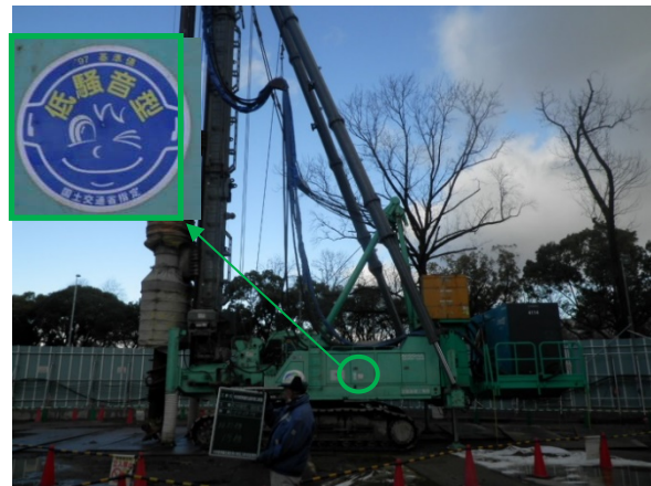
写真7-1-1-4 低騒音型建設機械の採用
